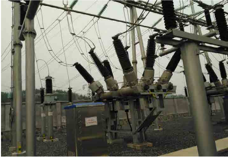
图3 220kV 远安变电站 110kV 扩建间隔侧现状
