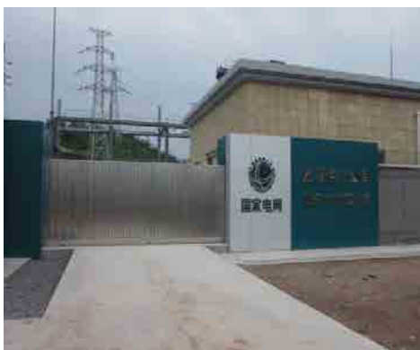
远安城东变电站进站道路
