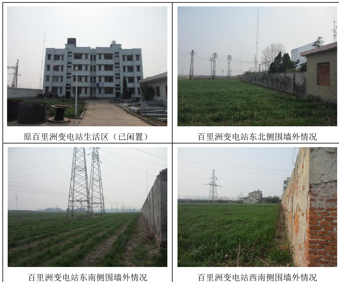
图 3 110kV 百里洲变电站周边现状图
