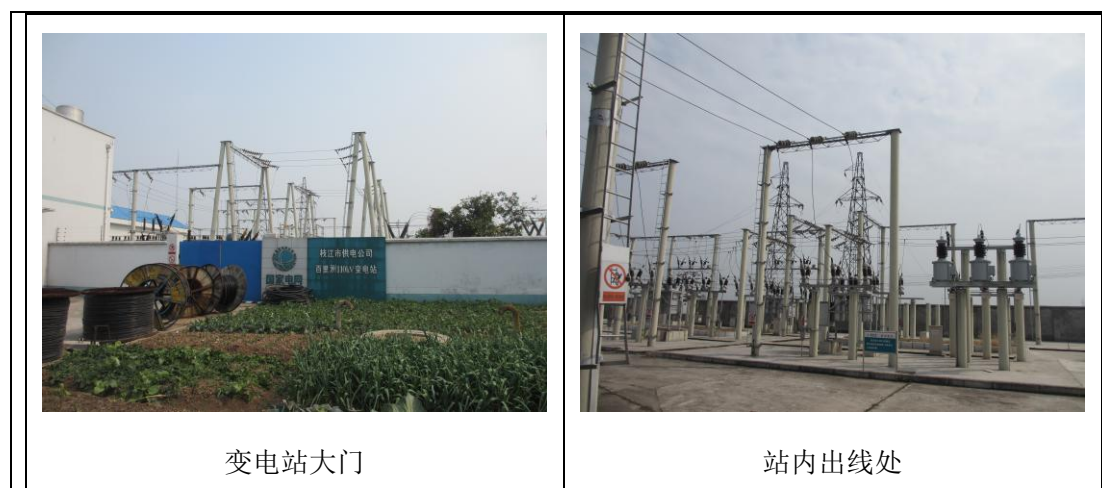
图2 110kV 百里洲变站内现状
