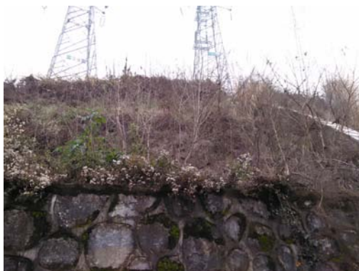
塔基植被恢复
