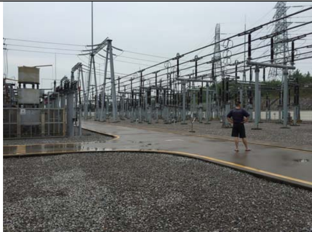
站内碎石硬化
