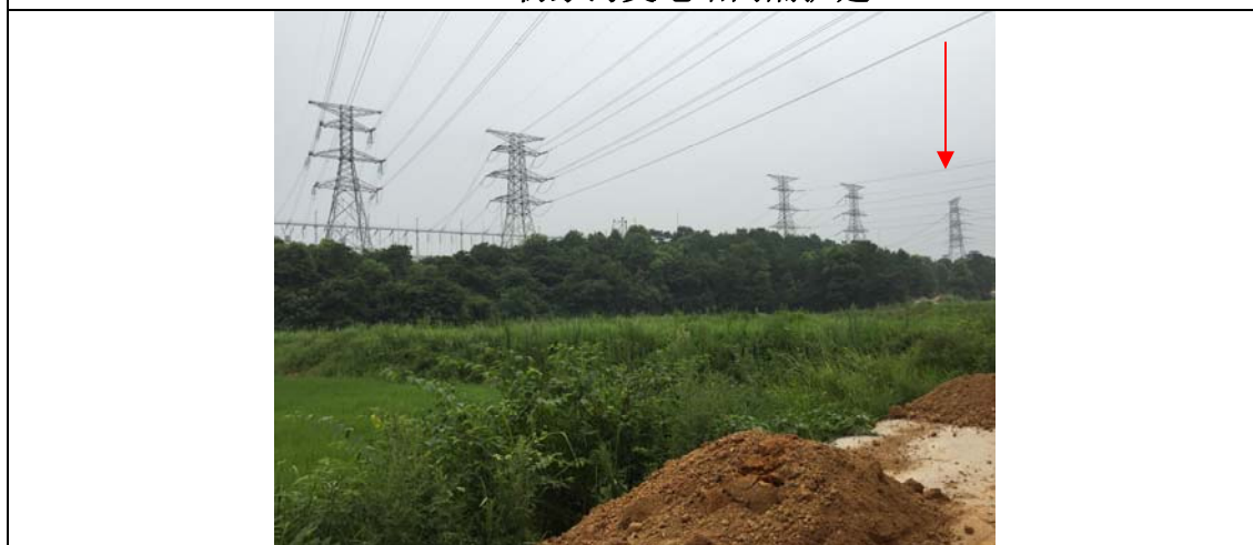
500KV 宜昌北变电站间隔扩建
