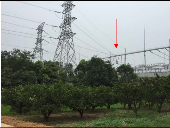
220KV 獠亭变电站间隔扩建
