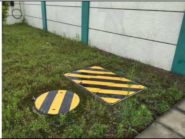
木店变内化粪池
