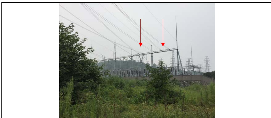
220KV 杨家湾变电站间隔扩建
