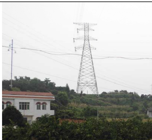
塔基植被恢复情况
