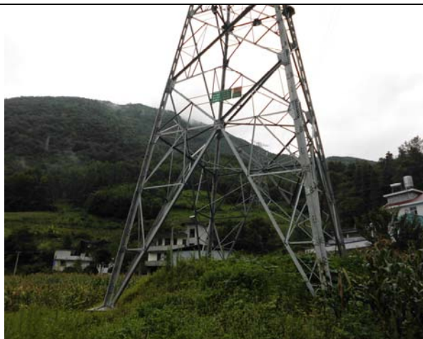
塔基植被恢复情况
