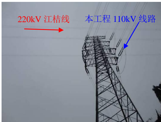
图 4-6 110kV 线路钻越 220kV 江桔线
