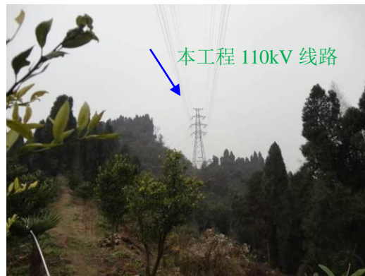
图 4-7 110kV 线路沿线地形
