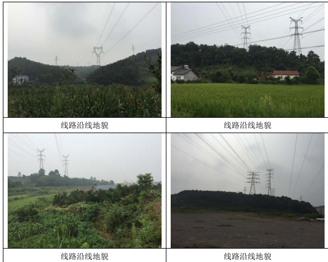
图2-1 线路沿线情况
