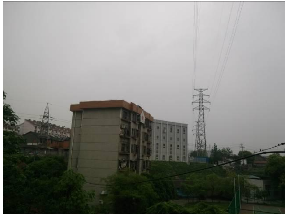
110kV 东湖变西侧围墙外现状照片
