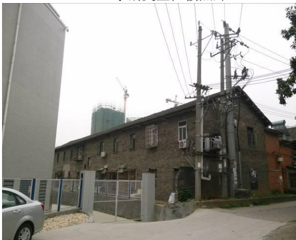
110kV 东湖变南侧围墙外现状照片
