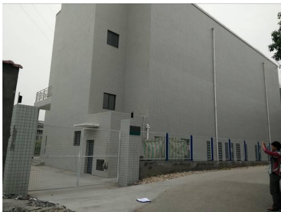
110kV 东湖变主控楼照片
