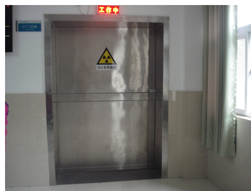
CT室防护门
