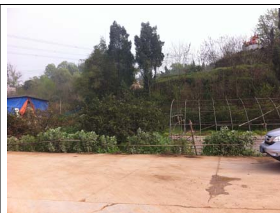
110kV 何家坡变南侧
